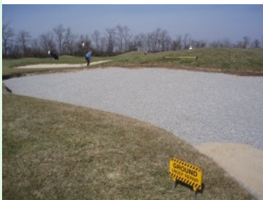
"Bunker under Repair" auf Loch 8
