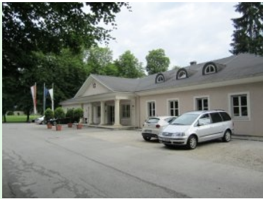
Das Clubhaus des Golf & Country Club Salzburg Klessheim
