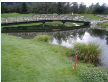
Die Hauser Kaibling Bridge am Grün 5
