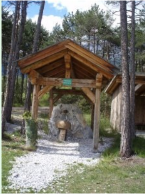
Trinkbrunnen an Loch 3
