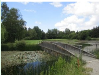
Brücke auf Loch 11
