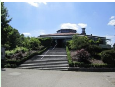
Das Clubhaus von der Parkplatzseite
