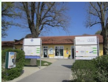
Das Sekretariatsgebäude & Shop
