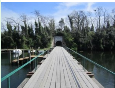
Zufahrt über eine Holzbrücke
