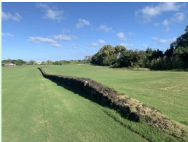
Steinmauer am Fairway 14
