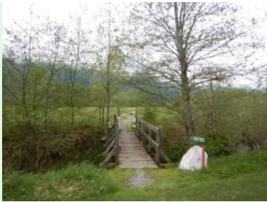
Holzbrücke am Weg zu Tee 4
