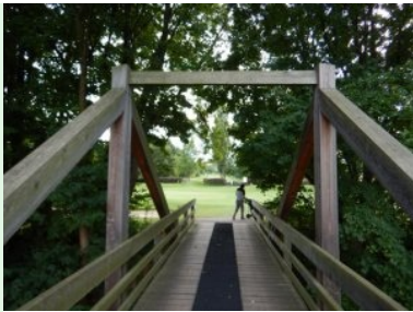
Am Weg zu Grün 27 - Brücke über den Göllersbach
