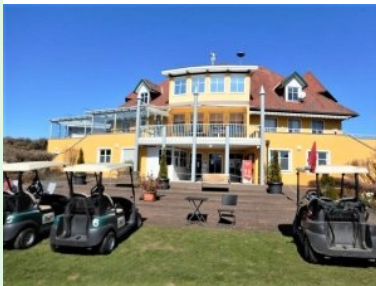
Clubhaus Hinterseite (vom Platz aus gesehen)
