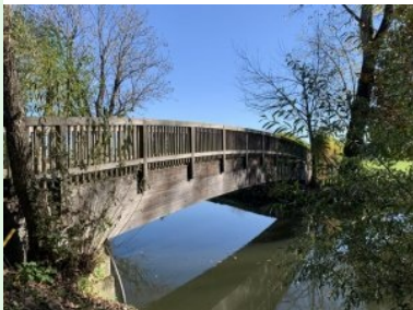
Wieder zurück über die Brücke
