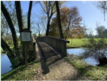
Brücke über den Mühlgang
