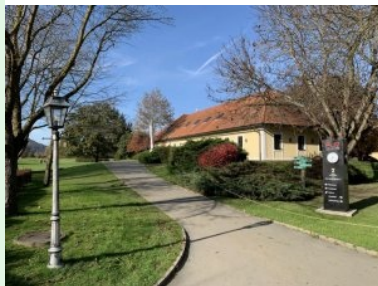
Zugang vom Parkplatz zum Clubhaus
