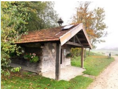
Schutzhütte am Weg zu Tee 13
