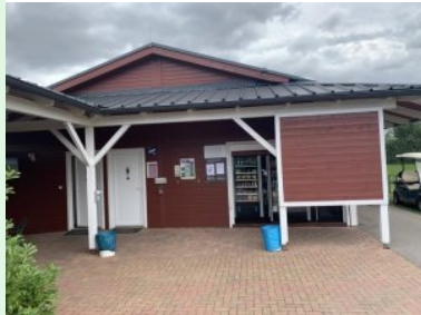
"Clubhaus" mit Getränkeautomat und Sanitäranlagen
