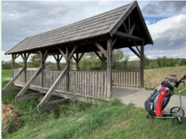
Holzbrücke über den Mühlbach
