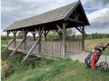
Holzbrücke über den Mühlbach
