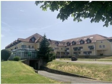
Zugang vom Parkplatz zum Clubhaus
