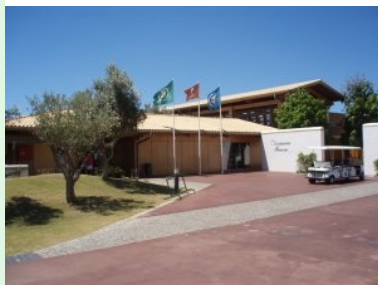
Das Clubhaus von der Zufahrtsstraße aus gesehen
