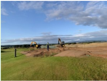
bauarbeiten für den zweiten Kurs "Old Petty"
