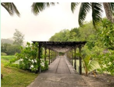
Holzbrücke am Weg zu Grün 9
