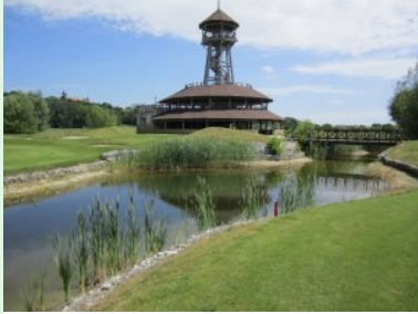
Das nicht fertiggestellte Restaurant mit Turm
