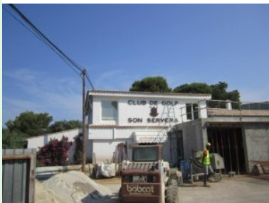
Das Clubhaus mit Baustelle (Juli 2015)
