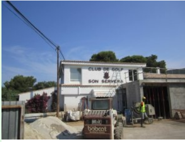
Das Clubhaus mit Baustelle (Juli 2015)
