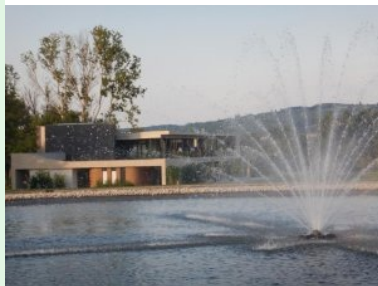
Blick vom Kreisverkehr auf das Clubhaus
