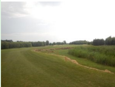
Erste Begegnung mit dem "geschwungenen Geländekante mit Steinplatten"
