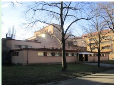
Der Eingang zum C19 im hinteren Teil des Waschsaloons
