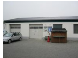
Der Eingang zur Outlet-Halle
